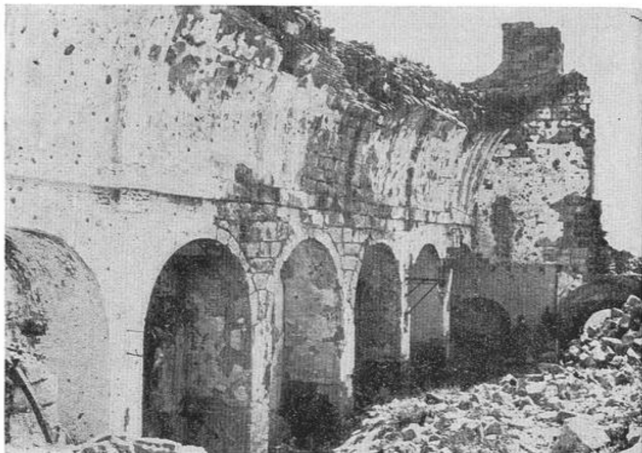
Estado en que iba quedando la nave central o iglesia del Santuario
